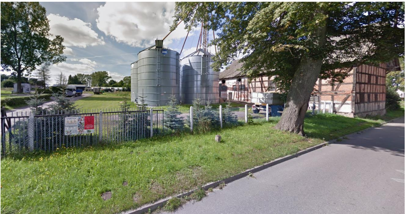
Zdjęcie 2. Widok z ulicy Ofiar Stutthofu na zabudowę obszaru objętego zmianą mpzp
